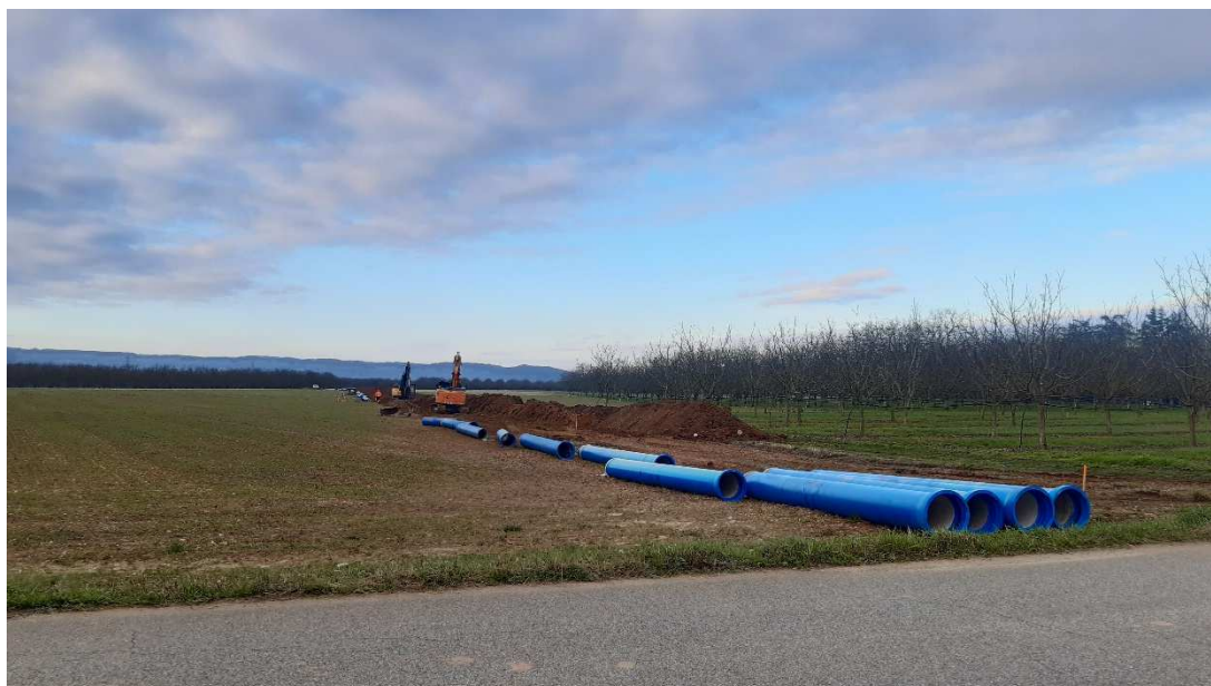
Pose des canalisations du réseau
