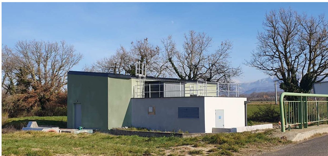
Couverture et insonorisation de la station de pompage de Montélier (réception octobre 2022)
