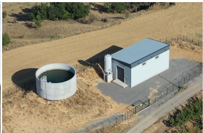
Réservoir et station de reprise des Roussons
